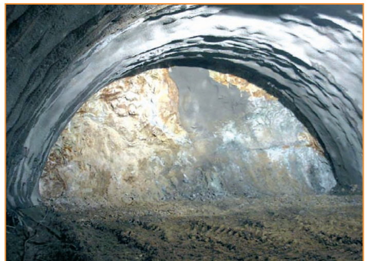
■ [Foto 2].- Frente excavado en zona de falla con granito milonitizado.
