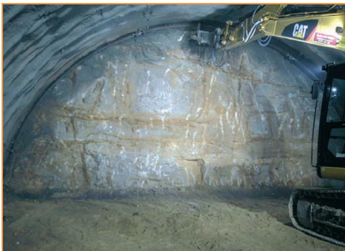
■ [Foto 1].- Frente excavado en granito con grado de alteración III-IV.
