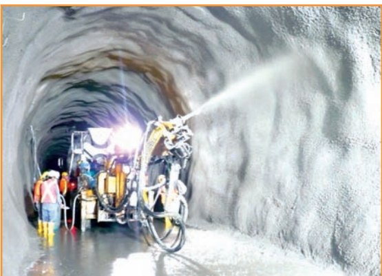
[Foto 8].- Proyección de hormigón para sostenimiento.
