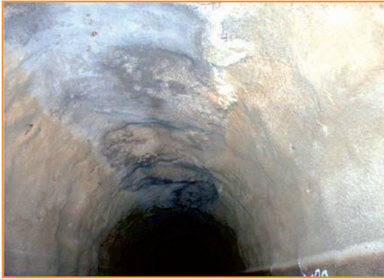
[Foto 2].- Rotura del sostenimiento.
