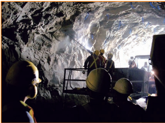
[Foto 7].- Colocación de bulones.
