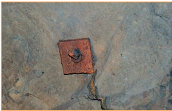
[Foto 3].- Perno dañado por corrosión.
