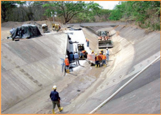
[Foto 6].- Rampa de acceso a través del canal.
