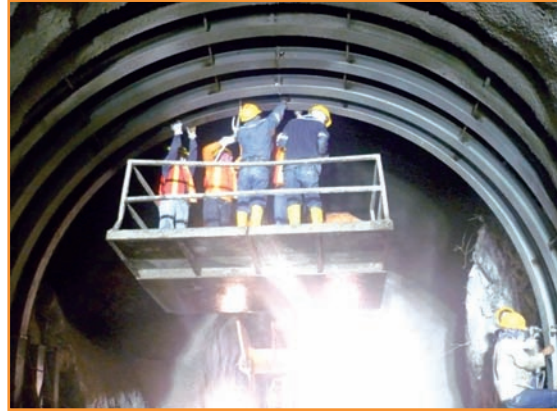
[Foto 9].- Trabajo en la caverna .
