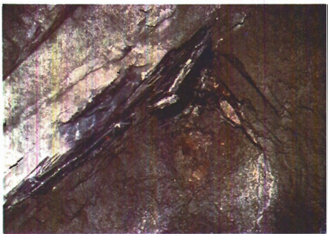
Foto 4. Discontinuidad producida por inclusiones.
